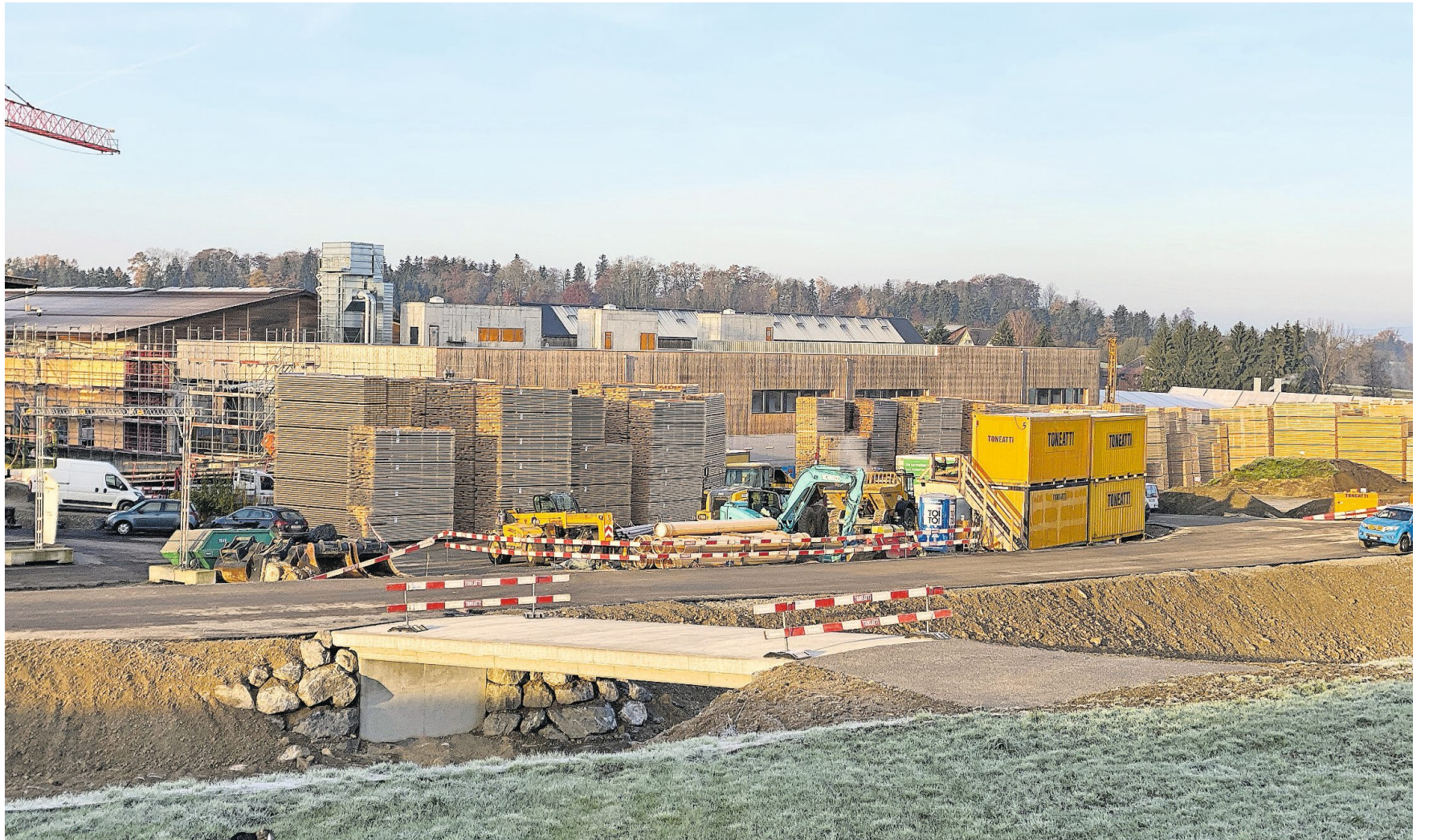
Baustelle Erlenhof: Der Loobach wird offengelegt und verlegt.
