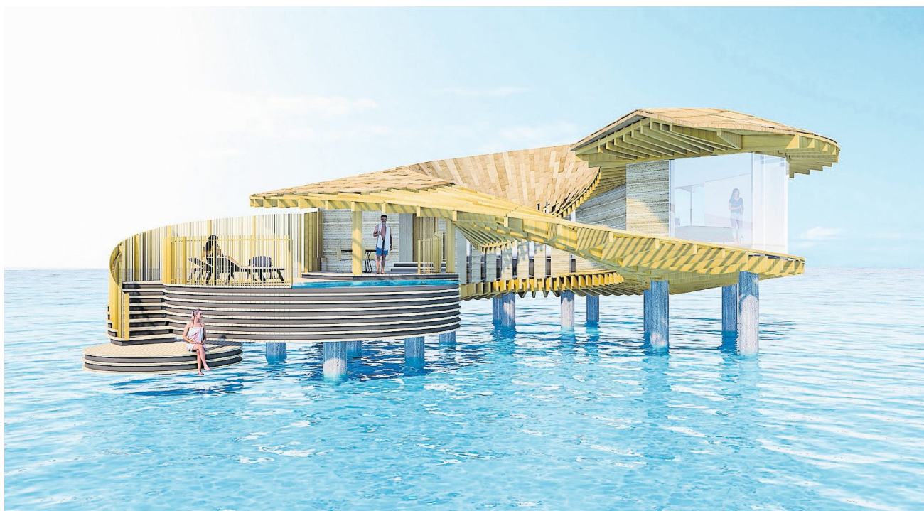
Einzimmer-Villa des Hotels 11 im Roten Meer; vorgefertigt werden die Villen im Erlenhof.
